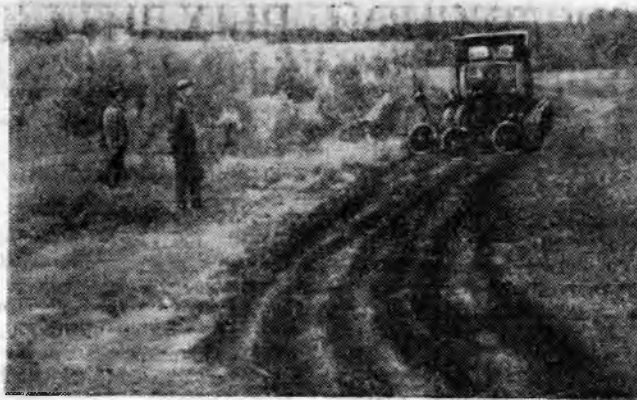
Рис. 3. Лесной рыхлитель-сеялка в работе.
