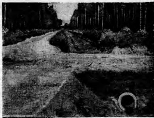
Рис. 2. Сборная железобетонная труба — переход облегченной конструкции на перекрестке квартальных просек (Видрижское лесничество, Мичукальский леспромхоз, Латвийская ССР).
