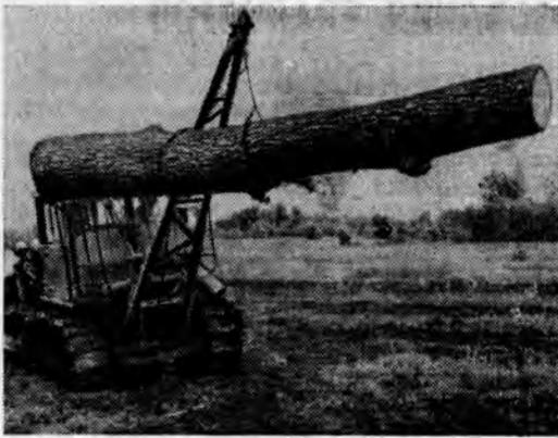
Рис. 2. Погрузочная стрела в работе (подъем бревна).
