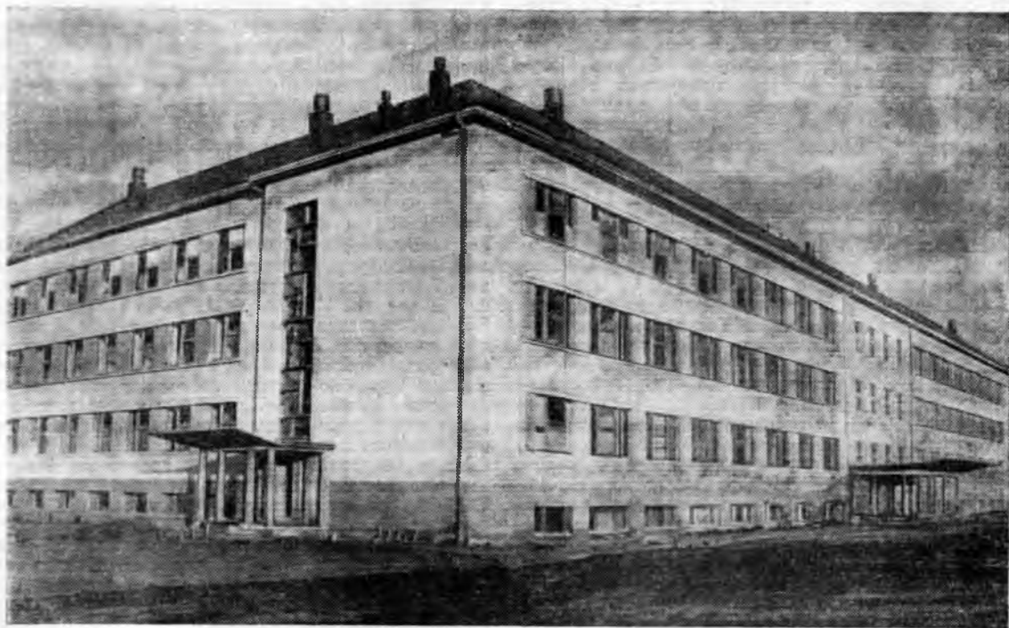
Недавно в Литве закончилось строительство здания Научно-исследовательского института лесного хозяйства. Здесь разместятся не только лаборатории института, но и учебные аудитории лесного техникума. На снимке: Новое здание Литовского научно-исследовательского института лесного хозяйства в г. Каунасе, в районе Дубрива.
