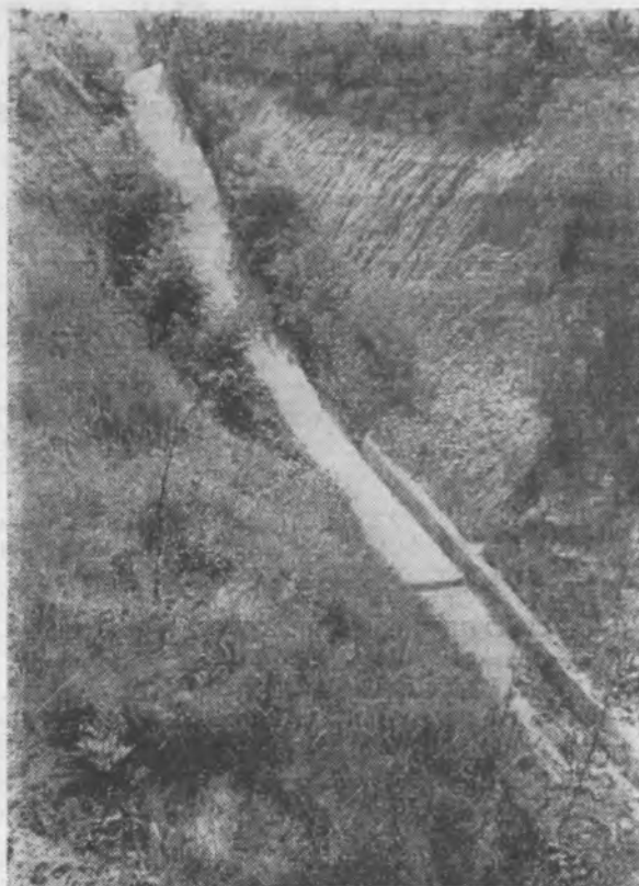
Рост вершины действующего оврага приостановлен сооружением лотка-быстроотка из железобетона. Кадаровский участок.
