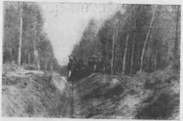
Проход грейдера для получения более пологих откосов после канавокопателя.
