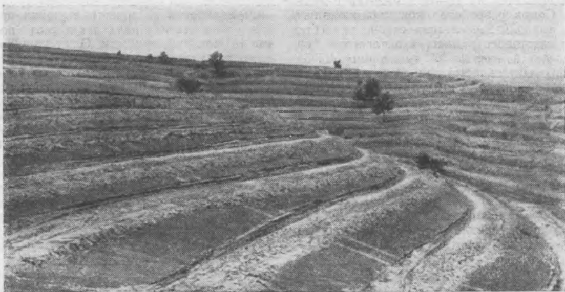
Террасы в урочище Пилява, созданные бульдозером Д-259. Каневский участок.
