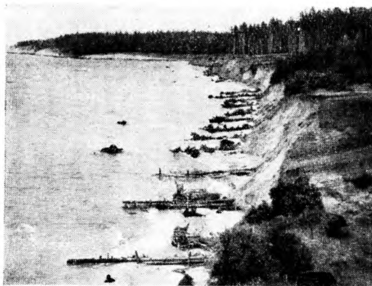
Рис. 3. Буны из пней на размываемом берегу Горьковского водохранилища
