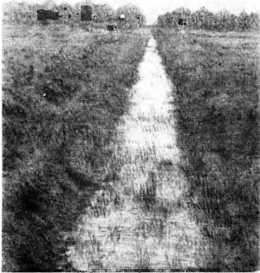
Заращение канала водолубивой растительностью
