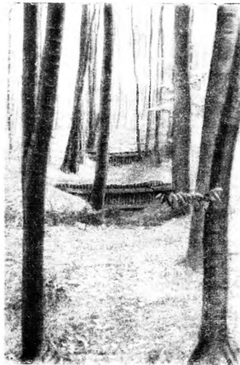
Деревянные запруды на логах для борьбы с эрозией почв в Вишеградском лесничестве
