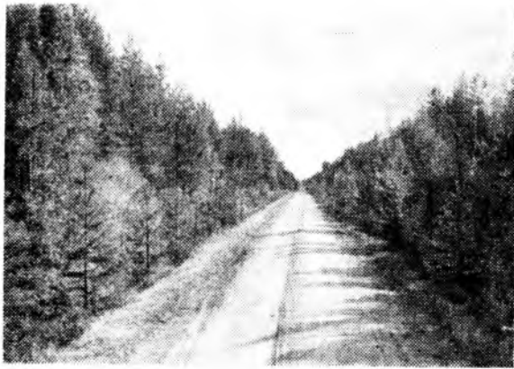
Рис. 3. Дорога с боковыми кюветами-осушителями (Сиверский лесхоз)
