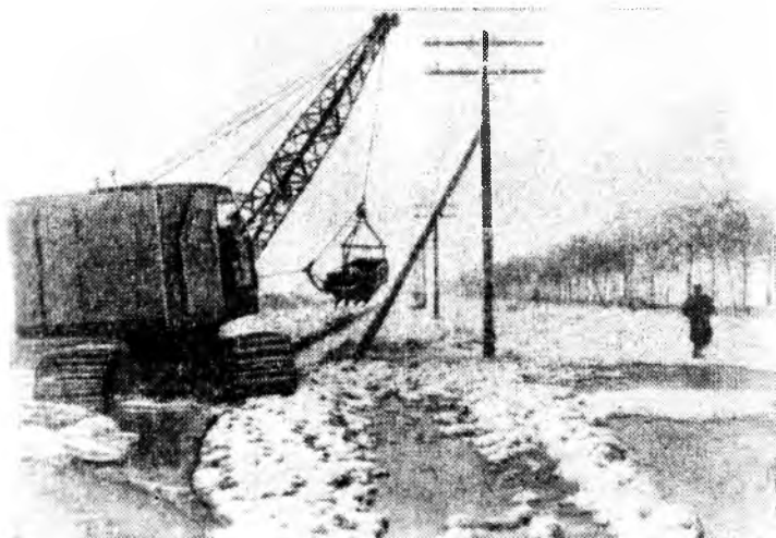
Прокладка канала второго порядка при помощи драглайна в Киверцовском лесничестве
