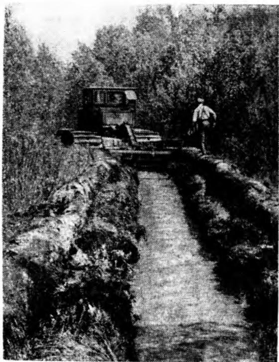
Рис. 1. Прокладка мелких осушителей при мелиорации вырубок навесным канавокопателем КН-600 (Сиверский лесхоз)
