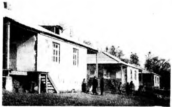
Жилые дома, построенные для работников Ноемберянского леспромхоза
