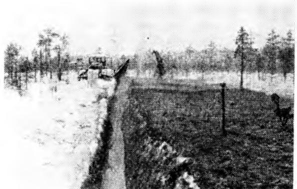
Рис. 2. Машина МК-1,2 на прокладке осушителя по болоту зимой. Справа от канавы широкая полоса, засыпанная торфяной крошкой
