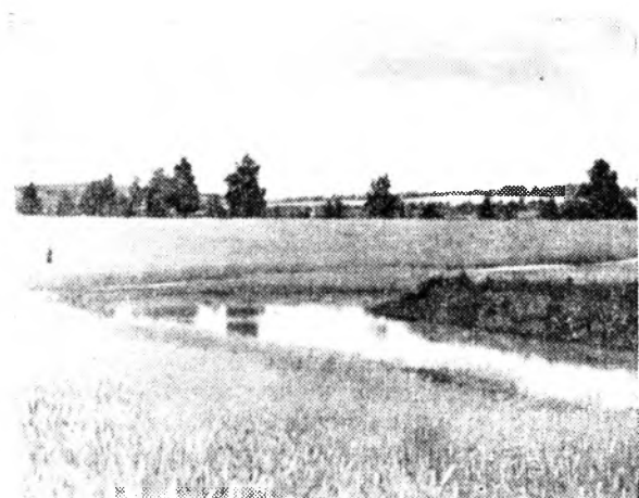
▲ Движение воды остановлено водозадерживающим валом в вершине оврага. Бучацкий участок
