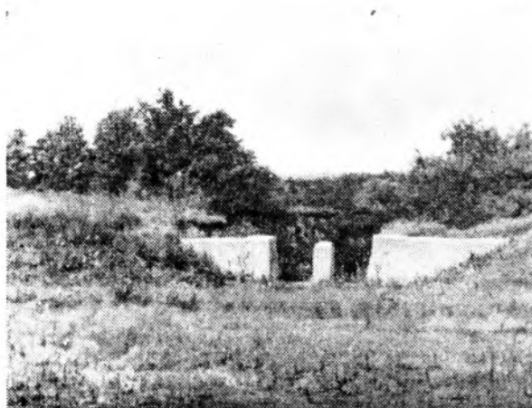
Каневское лесничество. Овраг надежно закреплен валами и водосбросом. Склоны и дно оврага облесены
