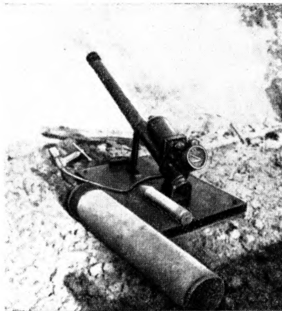
Метательная установка для поджигания лесосечных отходов на расстоянии (общий вид)
