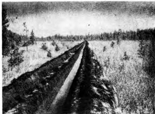
Канавы, прорытые реконструированным канавокопательным по гипново-осоковому болоту с зарослями карликовой березы
