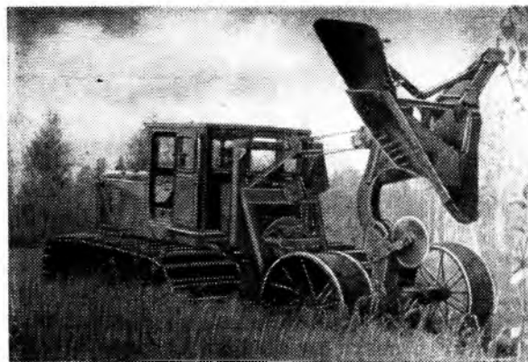
Канавокопатель с колесным передком в транспортном положении
