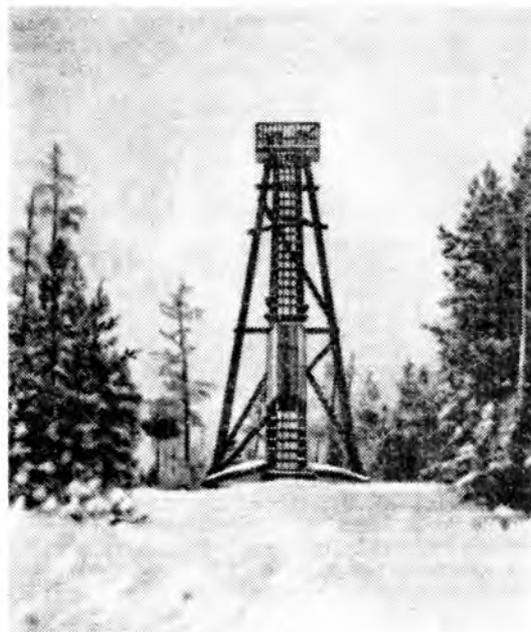
*Наблюдательная пожарная вышка типа «А» высотой 16 м, построенная в 1967 г. в Режевском лесничестве Режевского лесхоза*
