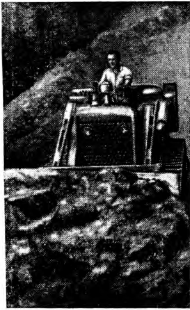
Строительство лесных дорог на склонах (планировочные бульдозерные работы)
