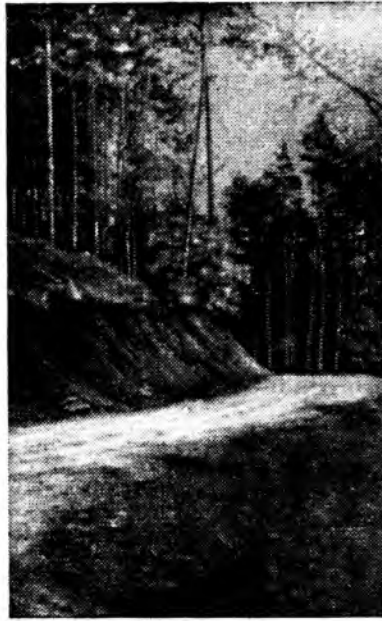
Строительство лесных дорог на склонах (готовое полотно)
