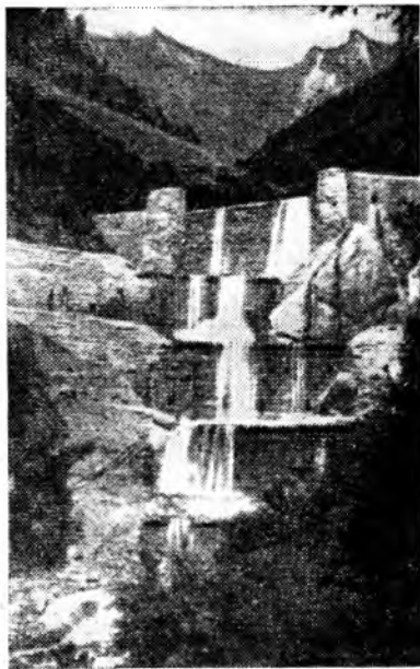
Инженерное сооружение по регулированию горных водотоков (барьеры Фалькенхайн)
