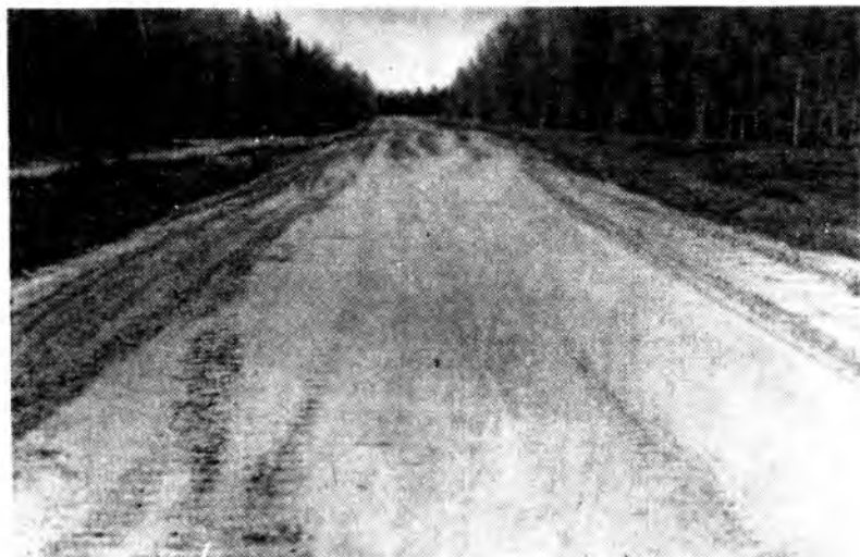
Рис. 2. Участок дороги с покрытием из грунтоцемента (доза цемента — 10%) после годовой эксплуатации (Солотчинский леспромхоз, Рязанская обл.)
