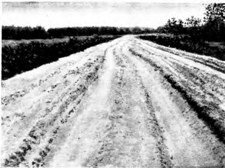
Рис. 1. Автомобильная лесовозная дорога на участке ст. Пилево — Родовицкий Мох (Клепиковский мехлесхоз, Рязанская обл.)
