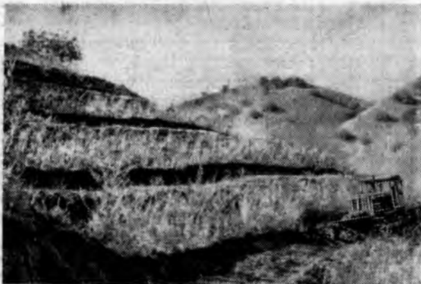
Террасирование горных склонов в Кушкинском лесхозе
