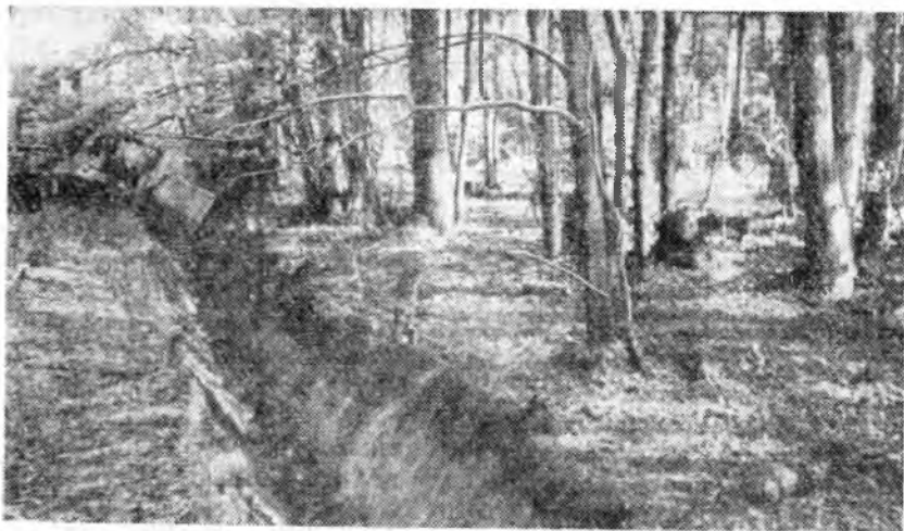
Канавоочистительная машина в работе. Вынутый грунт равномерно разбросан в стороны
