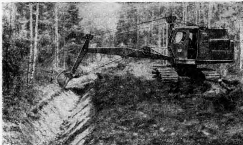
Экскаватор Э-304 на очистке внутриквартального канала
