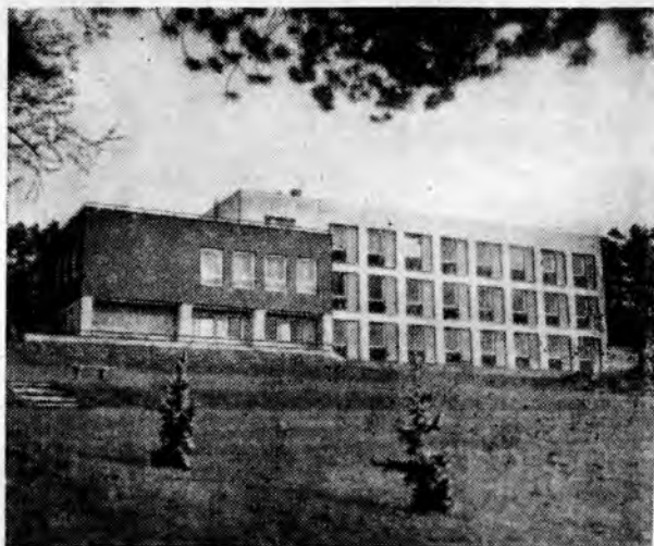
Здание научно-исследовательской станции НИИЛОХ в Кржтинах
