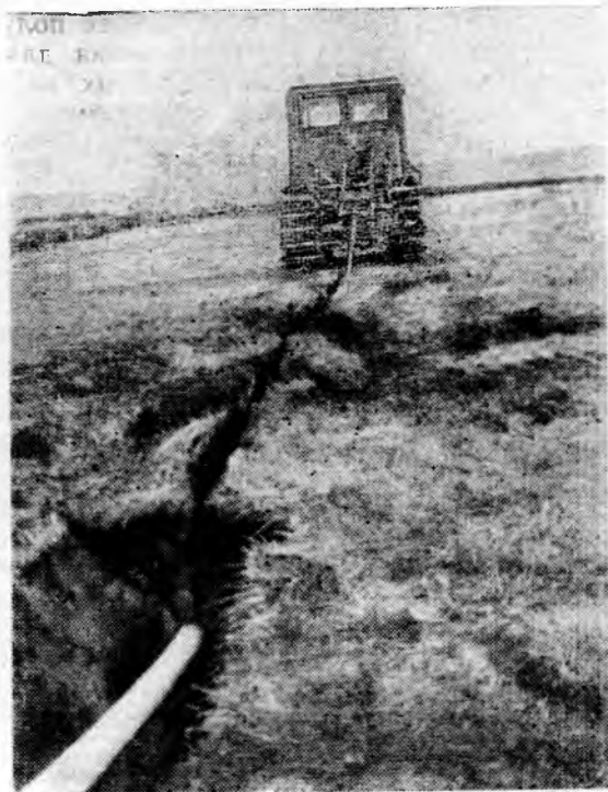
Рис. 3. Укладка непрерывного горизонтального цилиндрического заряда кротодренажной машиной
