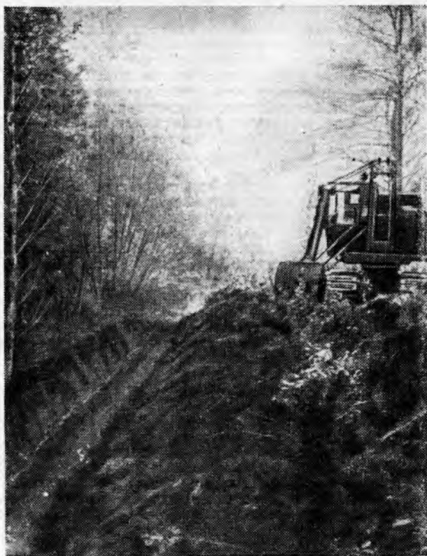
Рис. 3. Экскаватор Э-157 с ковшом поперечного черпания конструкции Горбунова на капитальном ремонте просечного осушителя в Славском ЛПХ. Грунт из канала выкладывается на просеку
