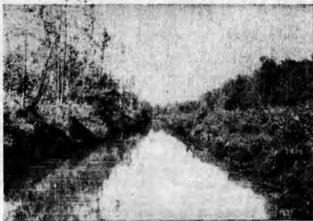
Рис. 5. Общий вид канала после очистки его взрывом непрерывного горизонтального цилиндрического (шнурового) заряда в лесу (Калининская обл.)
