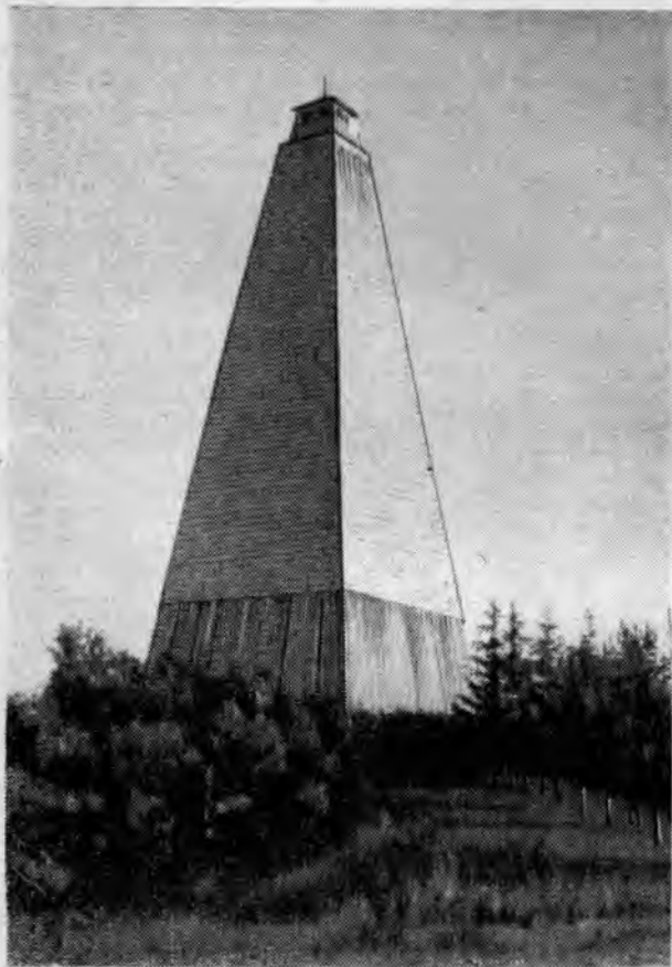
Крытая пожарно-наблюдательная вышка в Резекненском леспромхозе
