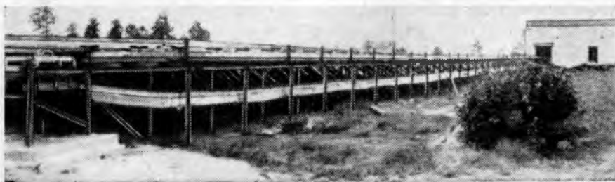
Строительство нижнего склада в Старобинском лесхозе
