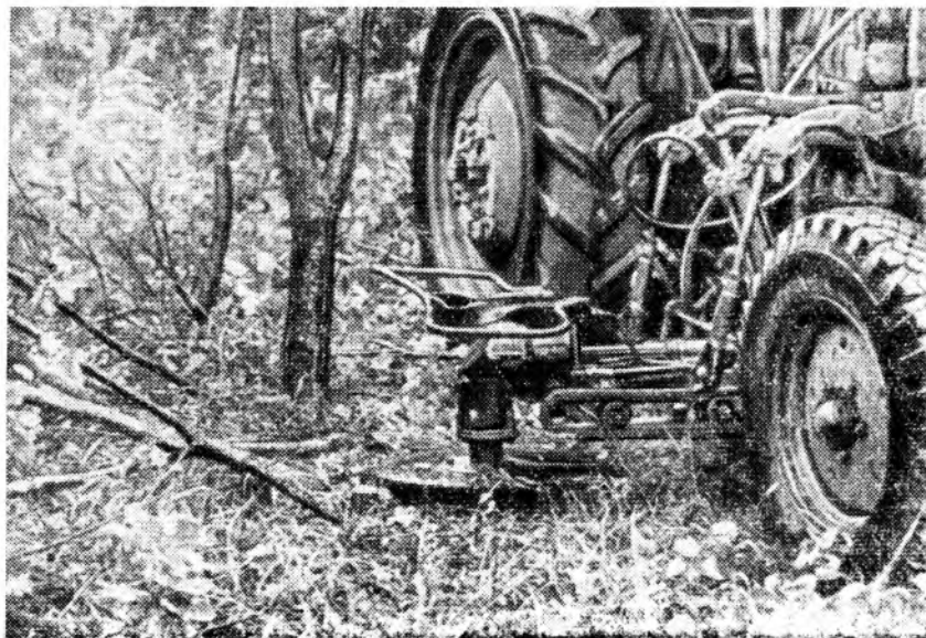
Рис. 2. Боковое приспособление к трактору МТЗ-5ЛС
