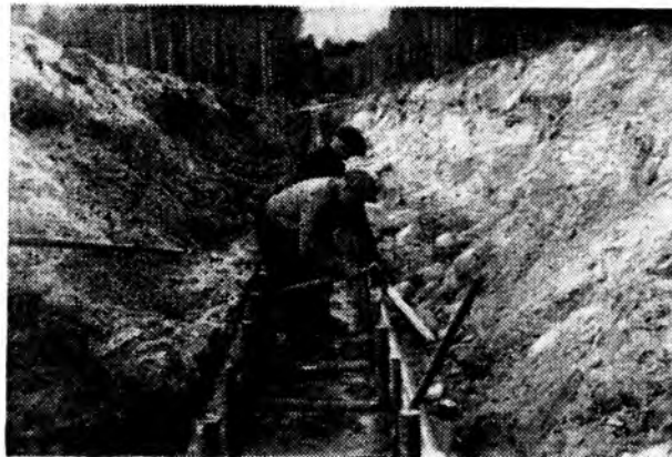
Строительство укрепления из жердей
