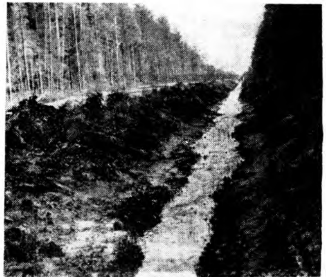
На неустойчивых грунтах каналы нуждаются в укреплении
