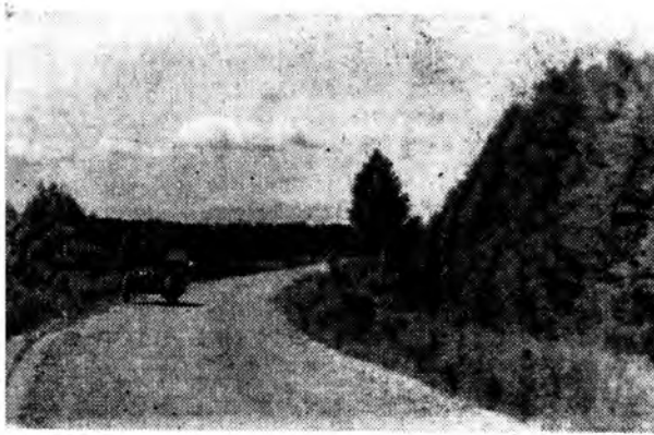
Лесовозная дорога с гравийным покрытием, построенная на объекте лесосошения
