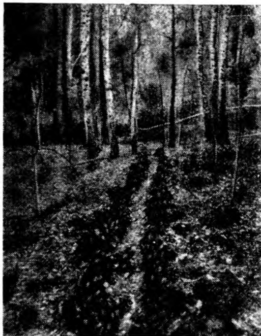
Рис. 5. Опорная полоса для отжига, полученная взрывом монозаряда
