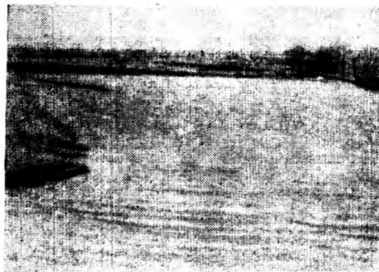
Рис. 4. Задержание вод ливневого стока валом-плотинкой в вершине оврага. Большой лог. Август 1972 г.
