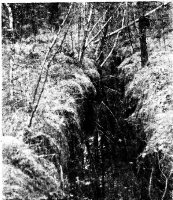
Рис. 2. Осушитель через 25 лет после эксплуатации без ремонта в пушицево-сфагновом сосняке
