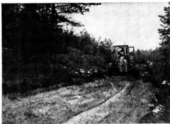
Строительство дорог в Рендском лесоучастке-лесничестве
