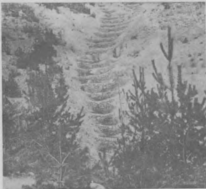
Противозрозионные укрепления
