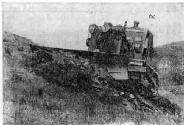
Рис. 3. Подготовка ступенчатых террас террасером ТК-4
