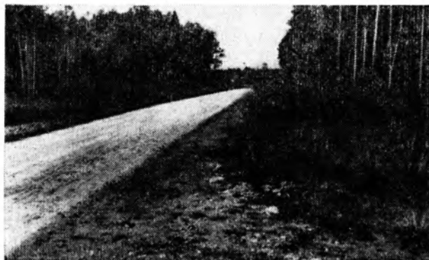
Лесохозяйственная автомобильная дорога с гравийным покрытием
