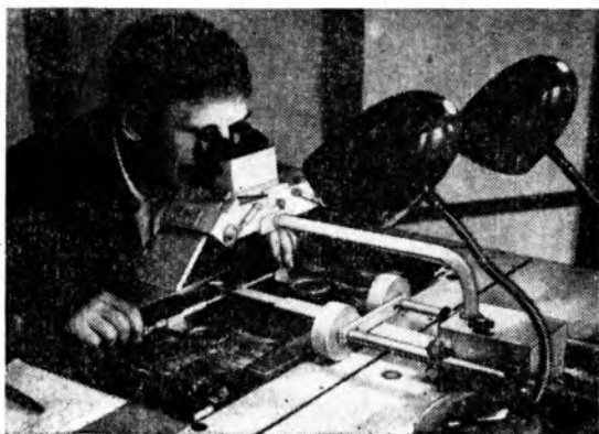
Дешифрирование аэроснимков с использованием стереопанометра
