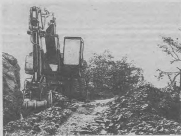
Рис. 3. Устройство траншеи-коллектора экскаватором ЭО-3322А на выемочной части полотна террас
