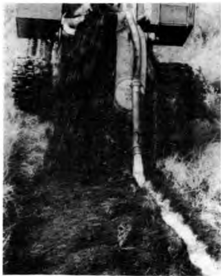
Рис. 2. Прокладка заградительного барьера из огнестойкой быстротвердеющей пены орудием ОЗТ-0,9
