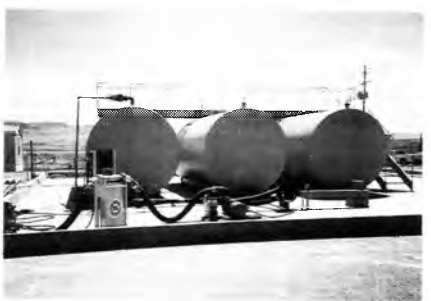
Рис. 5. Пункт заправки самолетов-танкеров химическими растворами
