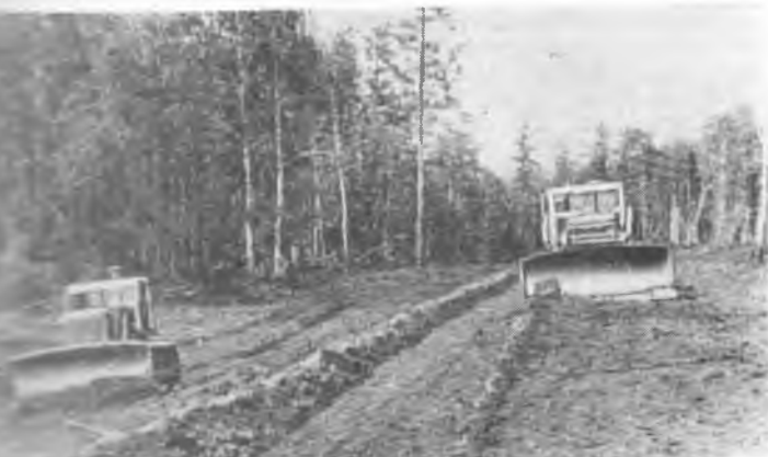
Устройство земляного полотна бульдозерами
