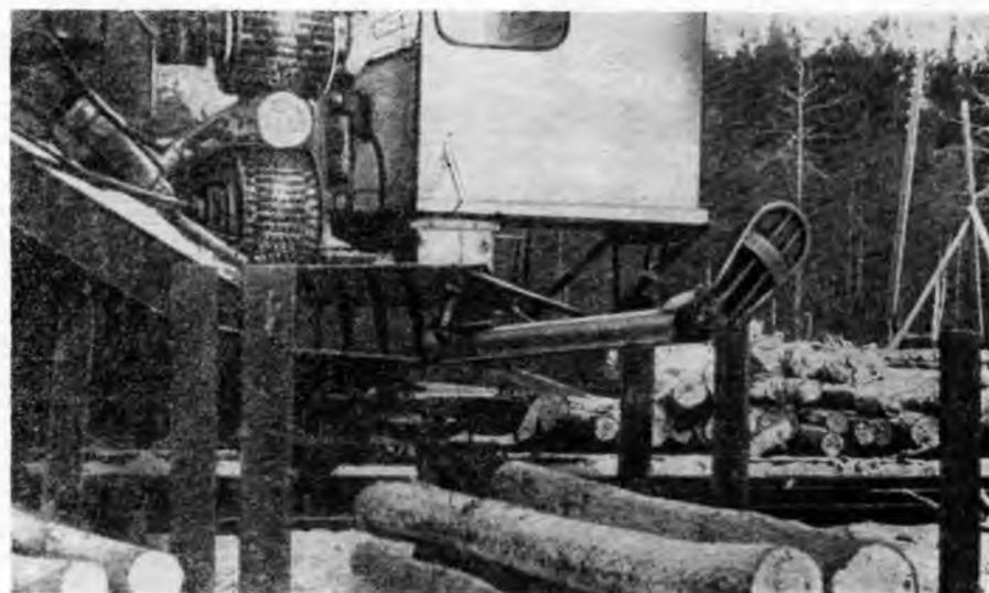
Рис. 1 и 2. Сброска сортиментов в лесонакопитель. Вверху — без опускания приемного стола; внизу — путем опускания стола
