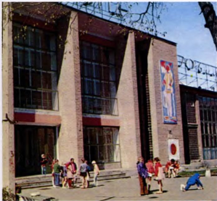
Панно в исполнении Г.А. Асафова на здании дворца спорта «Юбилейный» в Вологде. 1978 Panel created by G.A. Asafov at the building of sport centre «Yubileyniy» in Vologda. 1978
