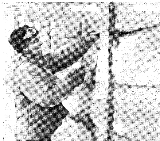
Рис. 2. Сооружение ракушебетонной перегородки.
