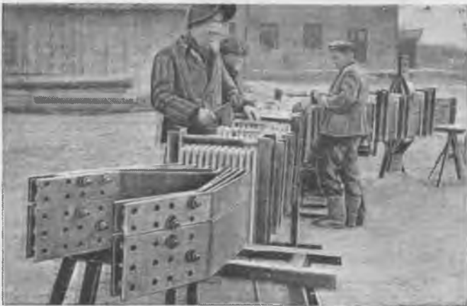
Рис. 3. Блок ошиновки электропечи, изготовленный и смонтированный в монтажной мастерской.
