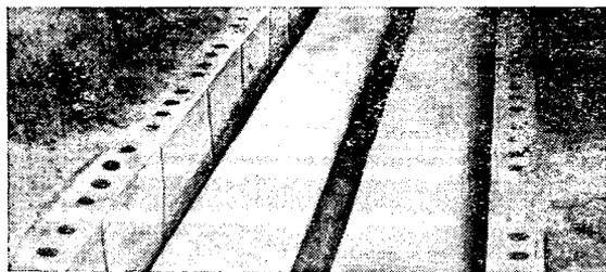
Рис. 3. Сборный канал из пустотелых бетонных блоков.
