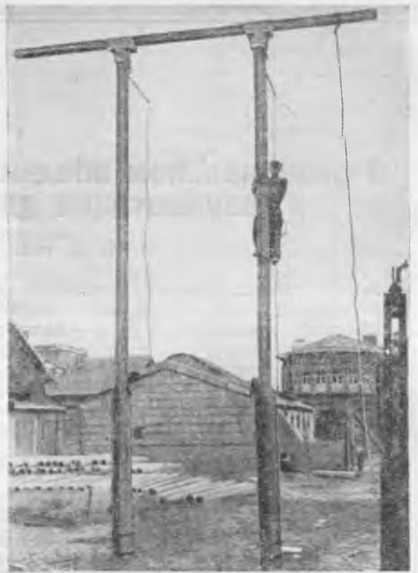
Рис. 3. Подъем монтера на опору из центрифугированного железобетона при помощи обычных когтей с прикрепленными к ним кусками кожи.
