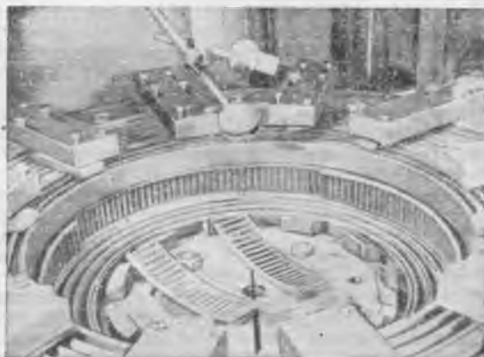
Рис. 9. Сборка радиальной ступени при облопачивании.
