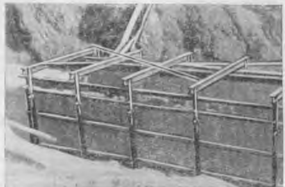
Рис. 2. Общий вид наружной опалубки.
