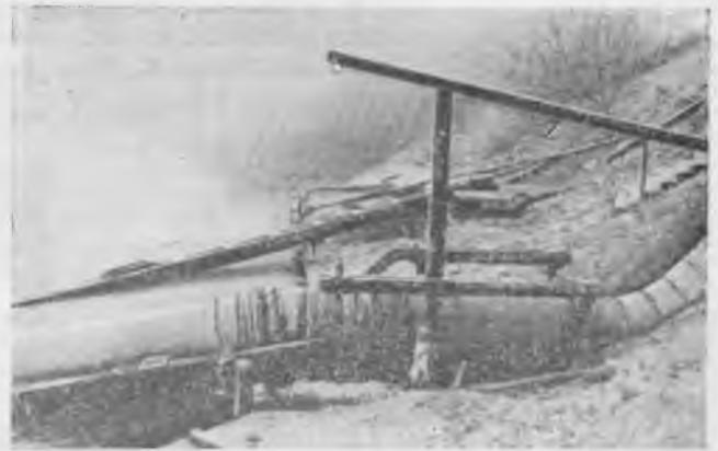
Рис. 4. Муфта гибкого соединения коллектора с береговым водопроводом.
