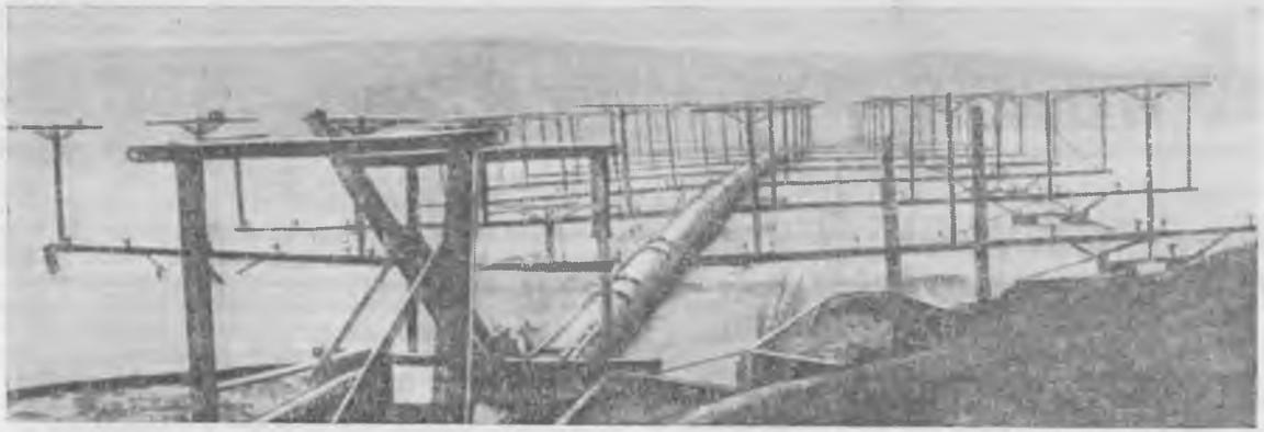
Рис. 3. Общий вид секции брызгальной установки (при опорожненных трубопроводах).
