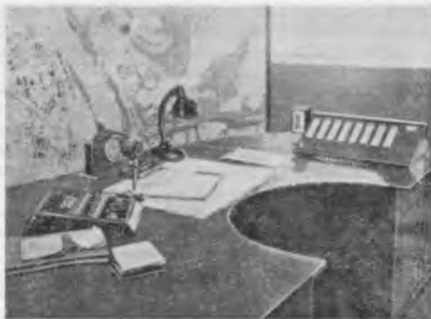
Рис. 2. Пульт-табло (ТУ — ТС), установленный на диспетчерском пункте.
