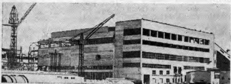
Липецк. Строительство агломерационной фабрики Липецкой Магнитки вступило в решающую фазу. Завершается сооружение главного корпуса агломерации и других объектов гигантского комплекса. Полным ходом идет монтаж сверхмощной агломерационной машины непрерывного действия площадью спекания 252 квадратных метров. Этот уникальный агрегат будет выдавать несколько миллионов тонн офлюсованного агломерата в год. По своей производительности и техническому оснащению он не имеет равных в мире.
