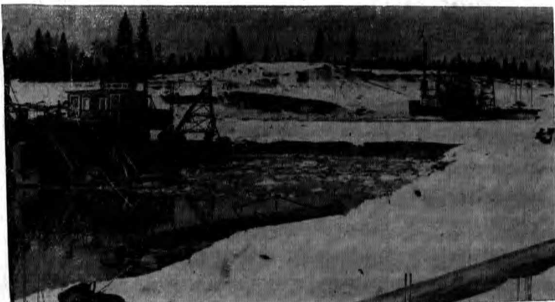
НА СНИМКЕ: Земснаряды № 306 и 301 завершают работы на последней перемычке в Анненском Мосту.
