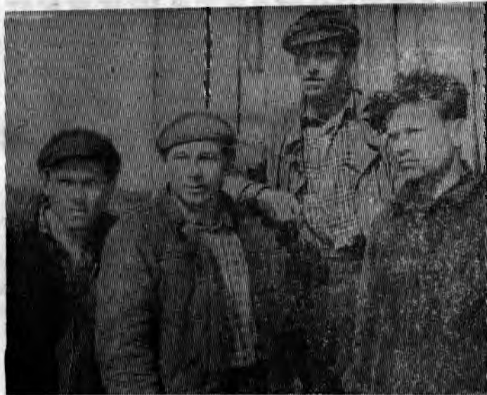
Б РИГАДА Виктора Швеца по своему составу небольшая — всего 8 человек, но эти боевые задорные парни на строительстве Пахомовского гидроузла выполняют большое дело: они были заняты укладкой бетона, установкой опалубки, выполняли плотницкие и другие работы на шестом шлюзе.
