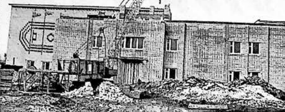
Идет строительство ФОКа.
