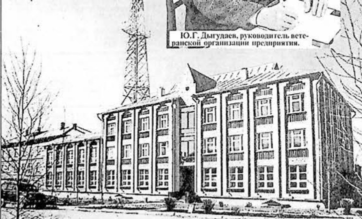
Главный офис Тотемских электрических сетей.
